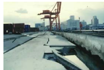
神戸地震における岸壁の被害
