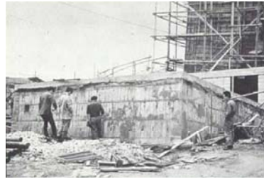
新潟地震における浄化槽の浮き上がり
