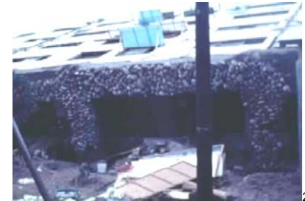
1964新潟地震 県営アパートの倒壊
