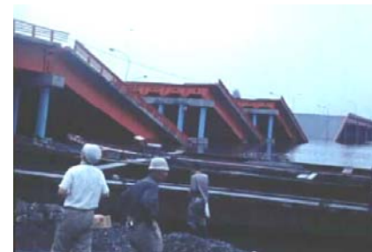
昭和大橋の落橋 地盤の側方流動における橋脚基礎の変位が原因??
